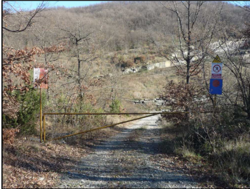
immagine 13 – foto ingresso cava
