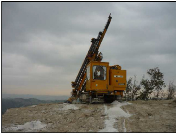
immagine 22 - perforatrice per fori esplosivo
