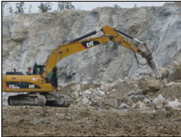
immagine 20 - escavatore cingolato con martellone
